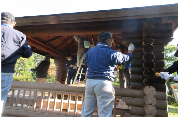
天井裏からベンチの下までもれなく塗装していただきました。
